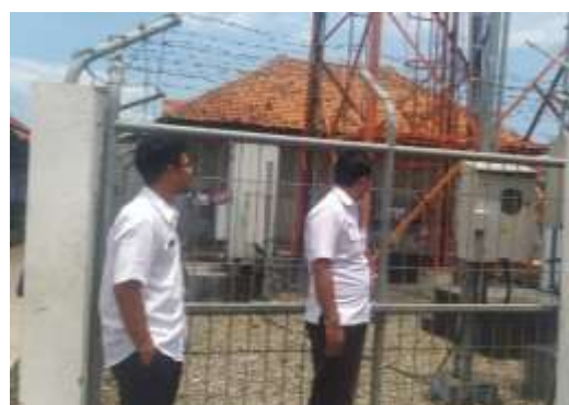
Kegiatan Monitoring Menara Telekomunikasi
